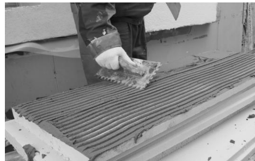
Рисунок 4 – Нанесення клейової суміші на ППС плиту суцільним способом
