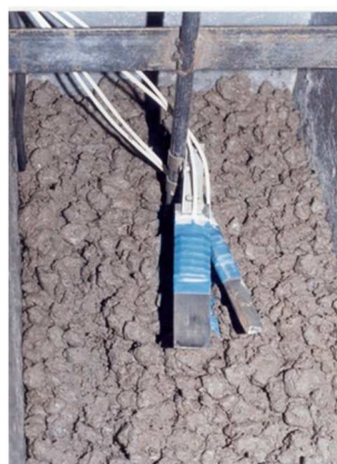
Завантаження бетонної суміші
