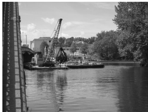
Рисунок 2 – Розчищення дна водойми з використанням екскаватора типу драглайн
