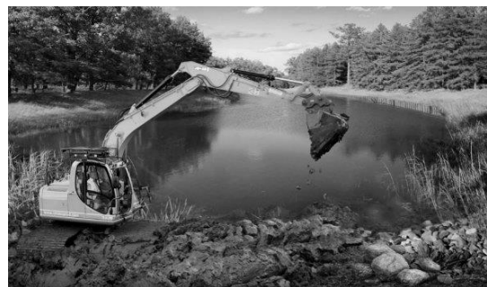
Рисунок 3 – Розчищення дна водойми з використанням екскаватора і вивантаженням донних відкладень на берег водойми
