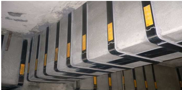
Рисунок 1 – Балочні конструкції підсилені зовнішнім армуванням
